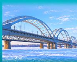
สะพานรถไฟพินโจว
